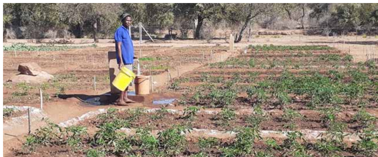
Les forages sont installés à proximité des jardins d'un hectare et permettent aux membres de la communauté d'arroser facilement leurs jardins. Crédit photo : SADC-GMI.
