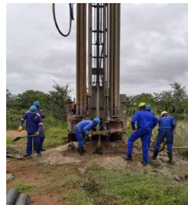
Le forage de Tsetsebjwe a été réalisé en février 2020. Crédit photo : SADC-GMI.
